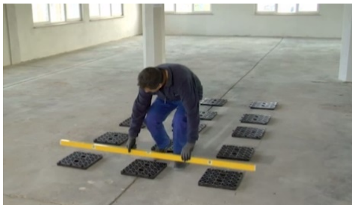
Sobald alle Platten auf dem Boden verlegt wurden, muss überprüft werden ob diese eben bzw. waagrecht liegen. Bei unebenen oder nicht waagerechten Flächen ist diese Differenz durch geeignetem Material auszugleichen.
