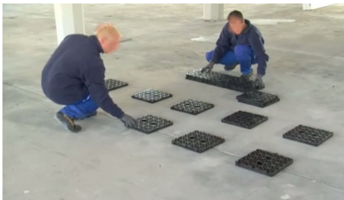
Für Zellen die im Temperaturbereich unter -5°C betrieben werden ist ein Unterfrierschutz erforderlich und müssen daher auf Unterlüftungsplatten aufgebaut werden.
