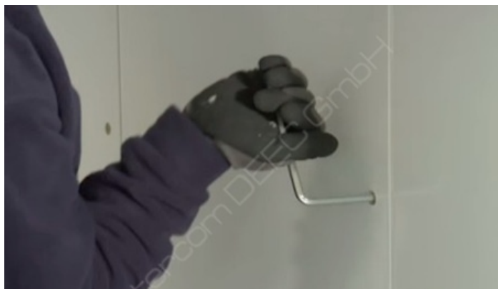
Die Wandelemente werden ebenfalls durch selbstzentrierende Exzenter-Spanschlösser verbunden.
