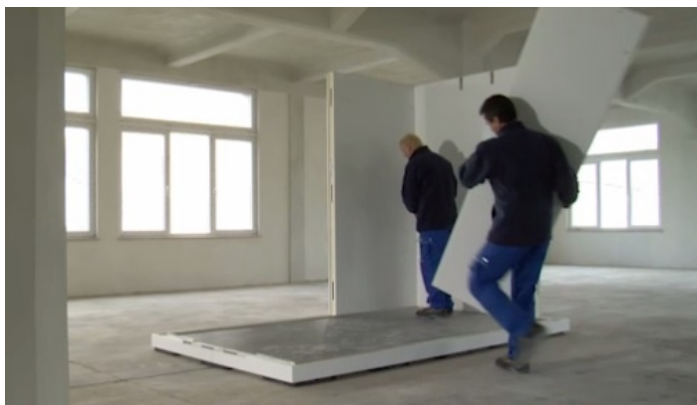
Die Wandmontage wird mit einem Eckelement begonnen.
