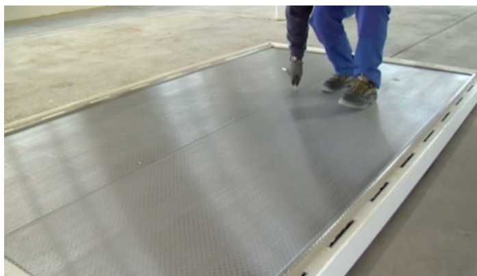
Die Bodenelemente werden zusammengeschoben und mit dem mitgeliefertem Innensechskantschlüssel festgezogen.
