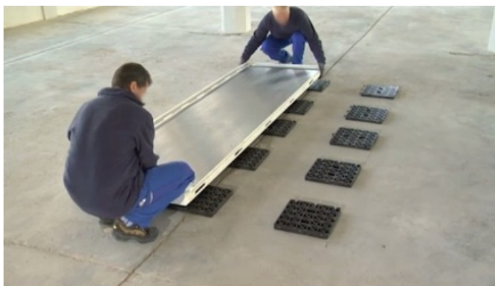
Die Bodenelemente werden nun auf die Unterlüftungsplatten verlegt.
